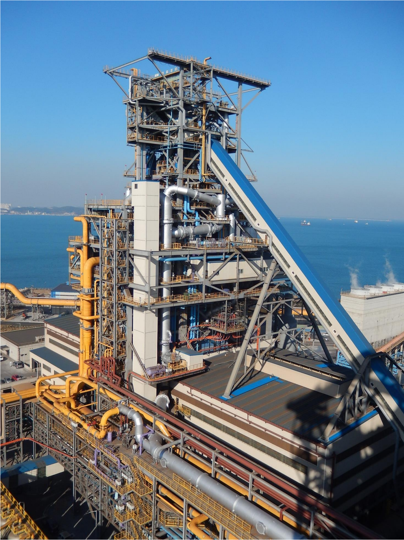
Finex Prozess zur Eisengewinnung (Posco Korea & Primetals Technologies Austria)
