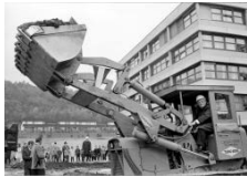
Spatenstich Physikgebäude Archiv JKU
