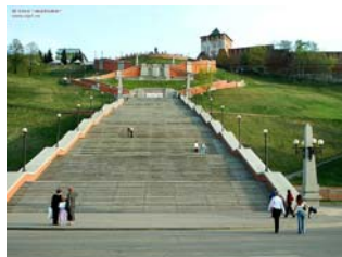
Tschkalov-Treppe, eines der Wahrzeichen der Stadt
