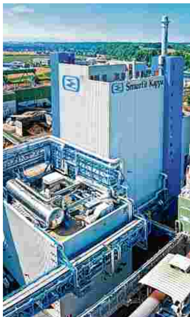
Die neuen Energieanlagen (Leutner)
