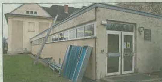
Wird gerade saniert: der Turnsaal der Linzer Keferfeldschule
